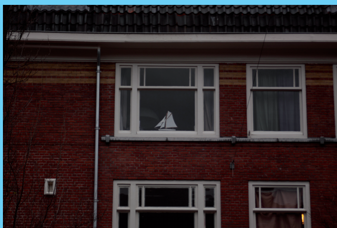
Detalle en ventana, Calle Scheldestraat, Amsterdam.
